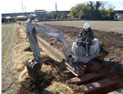
(開、排水路土砂除去)
